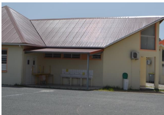
Nouvelles toitures dans les écoles.
