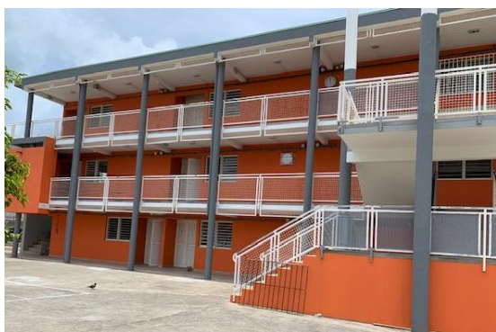
Nouveaux bâtiments au collège Mont des Accords.
