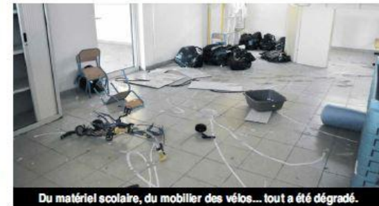
Du matériel scolaire, du mobilier des vélos... tout a été dégradé.
